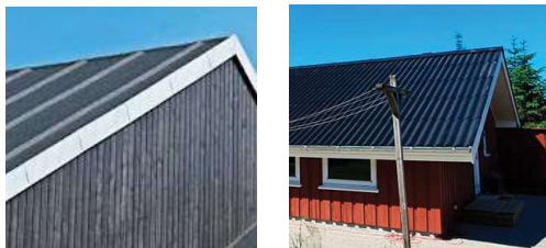
Ensidig taghældning min 5 grader
