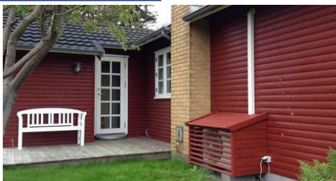
Eksempel inddækning af varmepumpe
